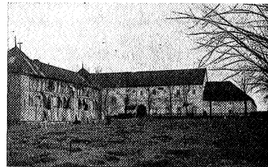
Vestfronten før restaureringsarbeidenes begynnelse.
