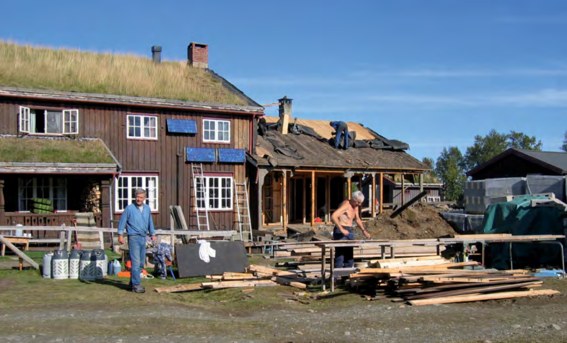
Utvidelsen av Jøldalshytta startet høsten 2004. Dette var et stort og krevende byggeprosjekt som det ikke hadde vært mulig å gjennomføre uten en imponerende dugnadsinnsats. Foto: Torgeir Gunleiksrud
