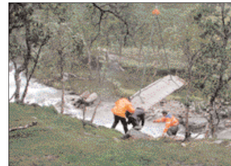
Det gamle bruspenet ble funnet og dratt fram med traktor. Helikopteret fra Airlift løftet det på plass ved det gamle brusedet over Litlsvartåa. Foto: Knut Balstad
