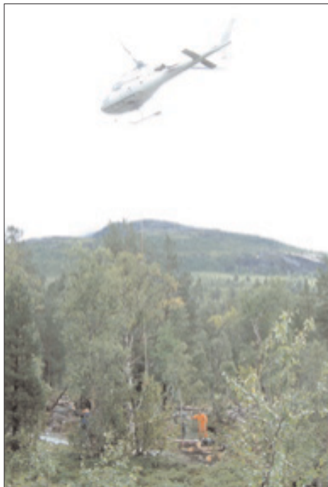
Fundamentene for brua over Slettåa er gjort klar. Helikopteret fra Airlift løfter det gamle bruspenet på plass. Foto: Sigmund Sørgerd
