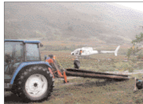
Det gamle bruspenet ble funnet og dratt fram med traktor. Helikopteret fra Airlift løftet det på plass ved det gamle brusedet over Litlsvartåa. Foto: Knut Balstad
