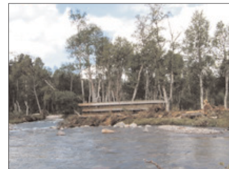
Restene etter Slettåbrua, som ble funnet noen hundre meter nedover elva, ble brukt som dekke til den nye brua. Foto: Sigmund Sørgerd
