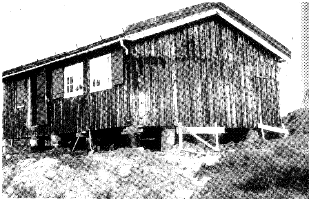
Hytta er jekket opp og nye søylefundamenter støpt.
