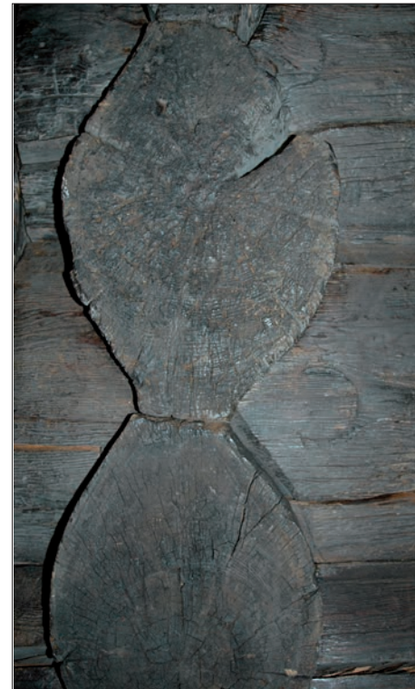
Jutulstuggu fra Uv i Rennebu ble reist av tømmer felt i 1249. Den ene tverrveggen av tømmerhuset er bevart på Vitenskapsmuseet i Trondheim
