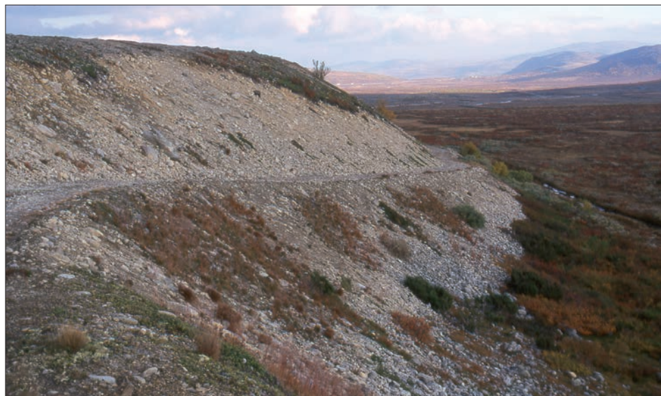
Utbedring av skader i bratt terreng, og med grove masser, kan ført føre til nye skader og erosjon. Bildet viser ei vegskjæring i den sentrale delen av skytefeltet. Foto: Dagmar Hagen
