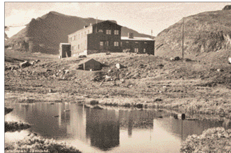
Sylstationen. Foto: H. Rotting, Storlien, postkort fra 1950
