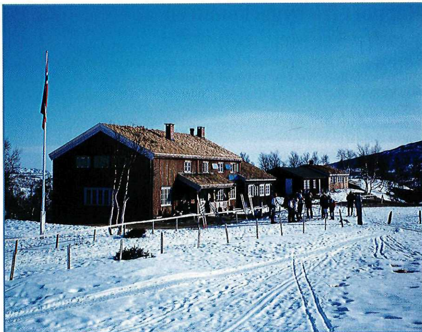
Jøldalshytta tar seg fint ut med nylagt torv på taket. I 1999 skal også torvlegginga på Trollheimshytta fullføres. Foto Erik Stabell
