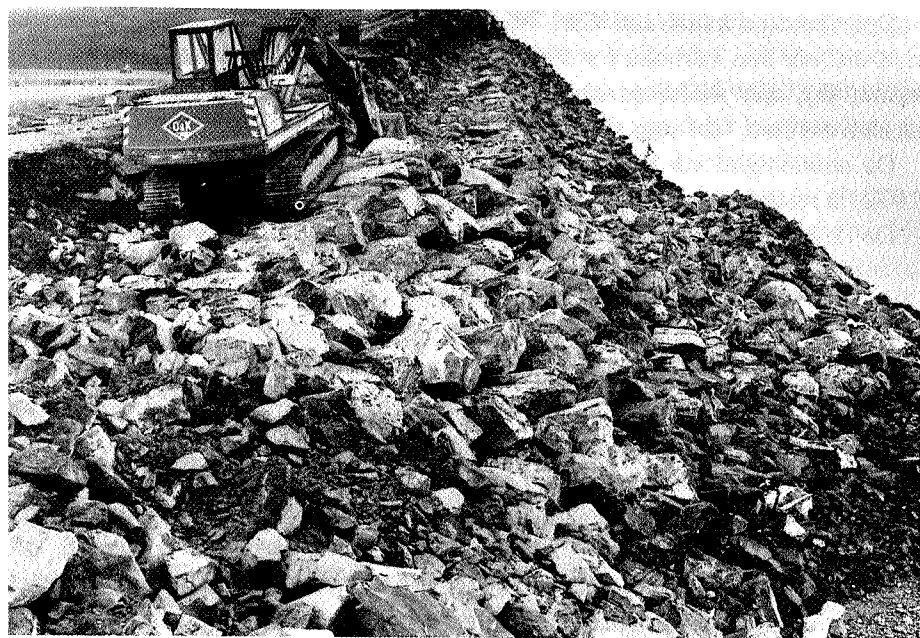
sjødemningen under arbeid, landskapet er forandret.
