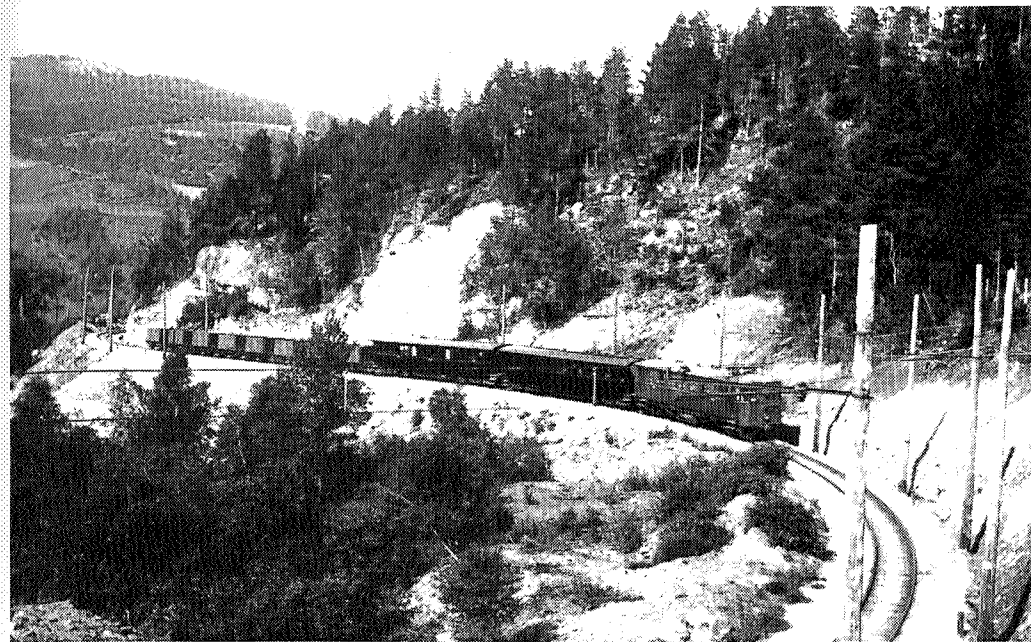
Passasjer- og godstog trukket av elektrisk motorvogn i stigningene fra Svorkmo mot Løkken, hvor det nå skal bli turisttrafikk på Thamshavnbanen.
