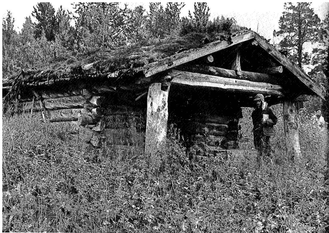
Overgrodd høyløe ved Røavollen. Rester av høyløer ligger tett i de frodige liene på Nerskogen, og de vitner om en storstilt utnytting av utmarksressursene i tidligere tider.
