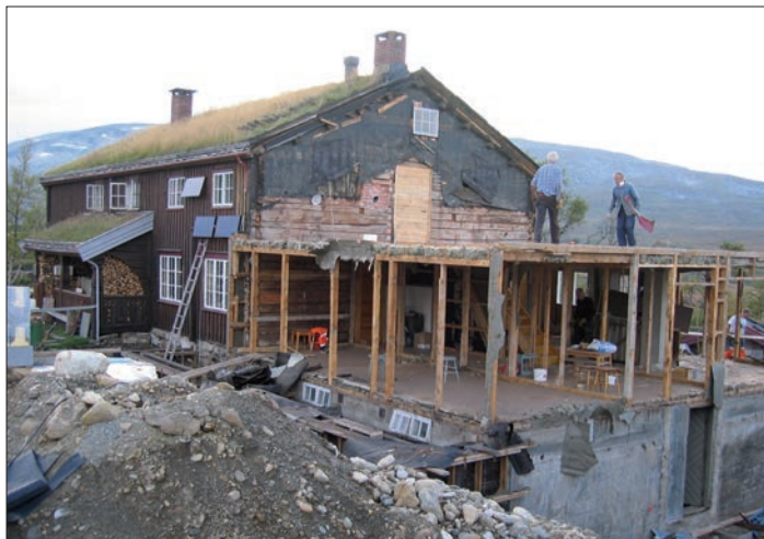
1963-tilbygget rives på dugnad. Byggegrøpa for tilbygget mot øst er klart. Foto:Torgeir Gunleiksrud
