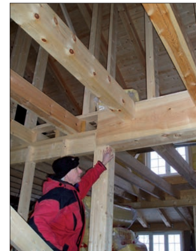
Byggeleder Kristian Tøndel studerer den svære takbjelken i spisestua. Foto:Jan Ivar Bruheim
