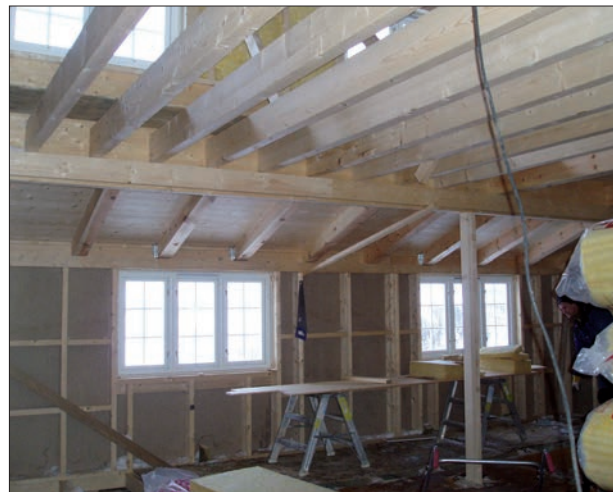
Spisestua under bygging. Foto: Jan Ivar Bruheim
