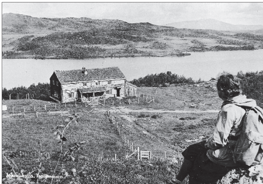
Den nye Jøldalshytta ble i 1917-18 bygget i to etasjer, med åtte soverom og 23 senger. Foto: Opdahl
