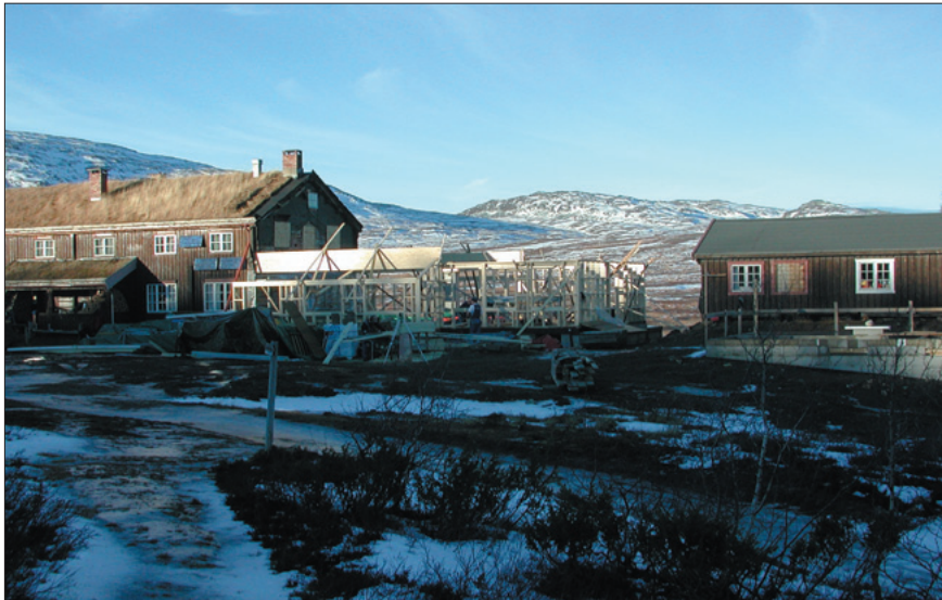
Nydelen av Jøldalshytta under oppføring i november 2004... Foto: Torgeir Gunleiksrud
