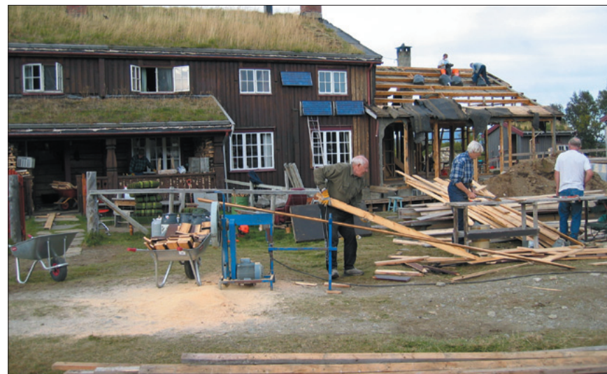
Under utvidelsen av "nye" Jøldalshytta ble det lagt ned mye dugnadsarbeid. Her fra dugnaden høsten 2004 der lauvfløya rives. Foto: Torgeir Gunleiksrud
