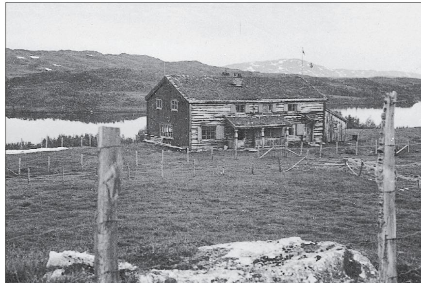
Det er værhardt i Jøldalen og hyttas vestvegg ble panelt allerede i 1922.
