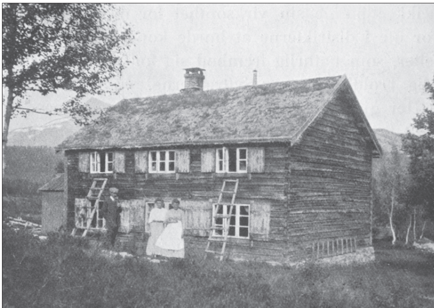
I 1902 ble TT pålagt sikringstiltak i tilfelle brann. Stiger ble reist opp til 2. etasje slik at folk skulle kunne komme seg ut.
