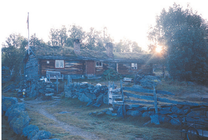
Seterbua utgjør hovedhuset på seterkvarteret Ljøsnåvollen. Foto: Erik Stabell
