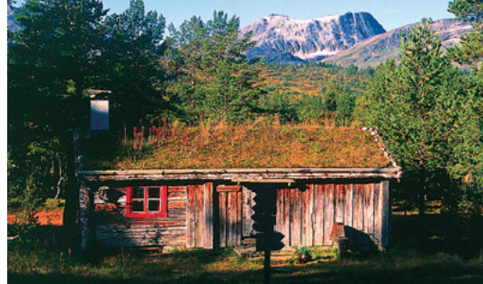
Den opprinnelige stallen – “Hoppogubbens hall”, nå kalt “Johan-stuggu” – på sin nye plass. Foto: Trond Emblemsvåg
