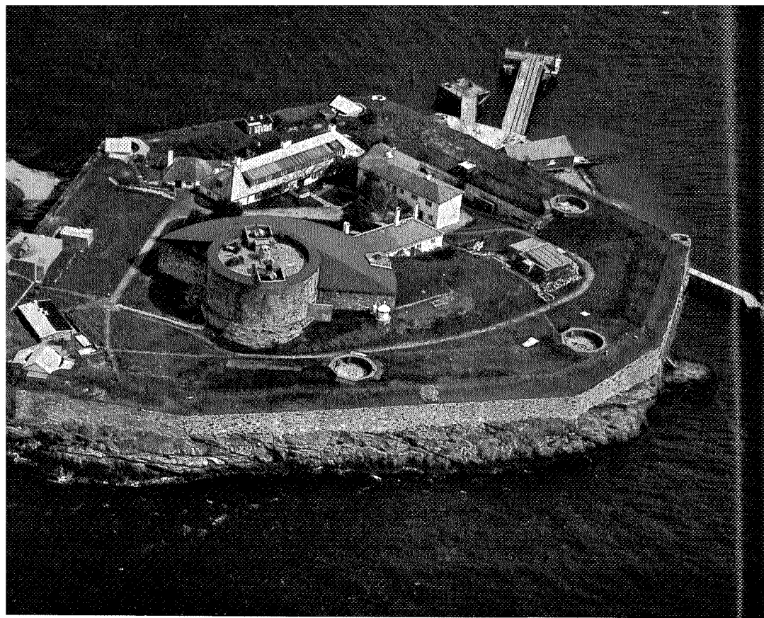
Munkholmen i dag. Tårnet påbygget og gitt flatt tak. Kommandantboligen har fått en lang, skjemmende ark. Bygningen til høyre for Kommandantboligen er påbygget en etasje. Bak tårnet sees det gjenstående av ringmuren.
