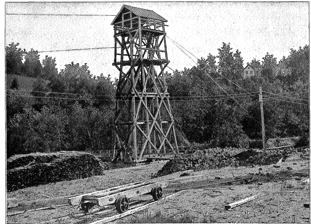
KRAFTOVERFØRING TIL BRUGET I HOMMELVIK.
